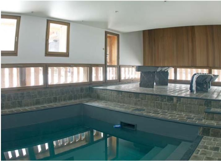
Quoique créée en excavant la cave, la piscine est inondée de soleil. Sol recouvert par les ardoises de la toiture d'origine. Table de massage et banc en blocs d'ardoise de Morzine issus d'une carrière souterraine locale.
