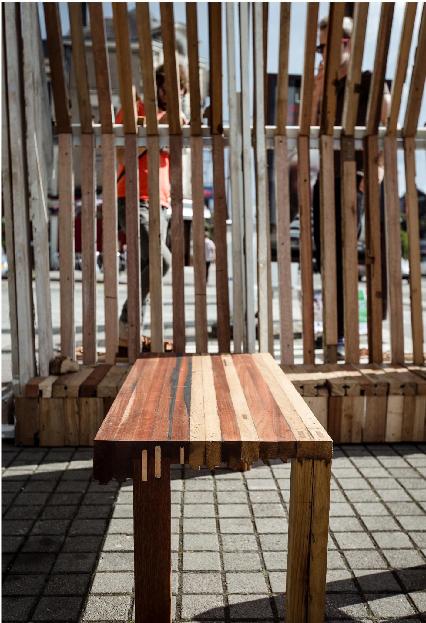
Después de haber pintado la estructura rosca-ron los listones de las ventanas utilizando tor-nillos de acero inoxidable. Algunos elementos fueron montados con varillas de acero inoxida-ble con el fin de permitir que algunos paneles pudieran girar.
