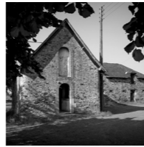
Ferme en son état existant
